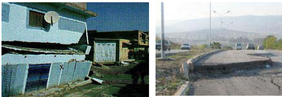
Figure1.5 : Effondrement de la ville de Cheria en 2009
